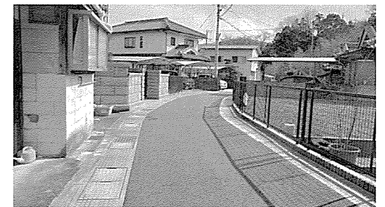
▲町道107号線（永代地区）
