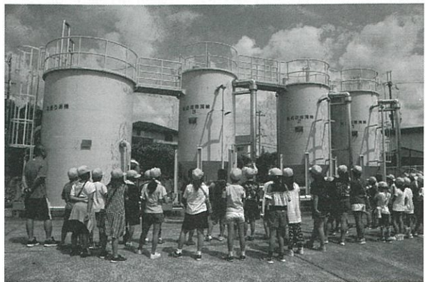
▲九度山浄水場
